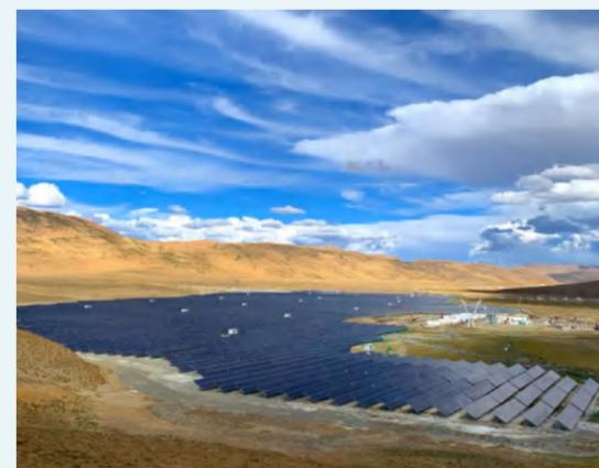
项目预期年发电量约 7200 万千瓦时，相当于节约 2.62 万吨标准煤，减少温室气体排放 7900 吨，减少二氧化硫排放 2400 吨。由于配置了大容量储能系统，项目可作为稳定电源在夜间提供电力，为日喀则提供清洁、可靠的绿色能源，对西藏电网调峰、调频、调度具有重要示范意义。
